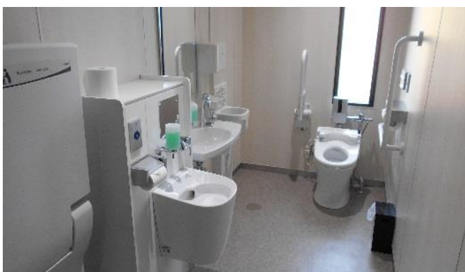
3号館多目的トイレ
