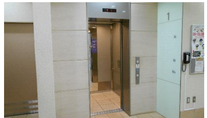
11号館エレベーター
