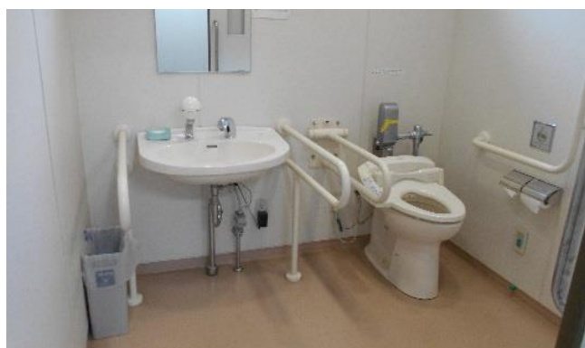
4号館多目的トイレ
